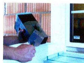
Presser MTH ELEMENT DE FIXATION INTERNE EBRASEMENT Tra-Wik-PH au ras des panneaux isolants, dans la partie fraisée.
