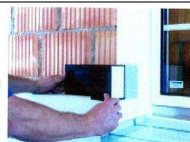
Une fois le mortier adhésif durci, appliquer les fixations mécaniques.
